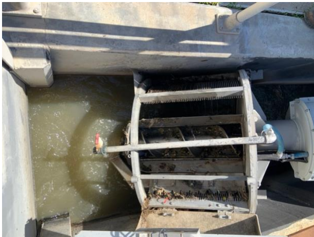
Modern Auger-Type Finescreen (Las Vegas WWTF)
